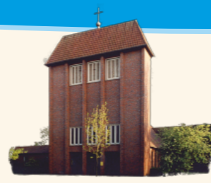
Martin-Luther-Kirche Mittelweg 5, Nordenham
